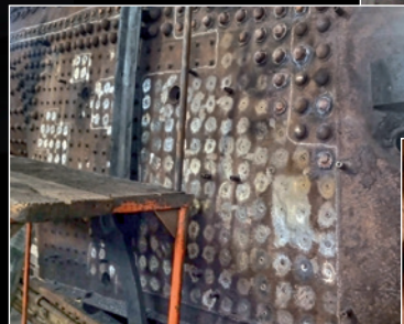
Arbeiten am Kessel.
