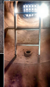
Ausbau von Heiz- und Rauchrohren.
